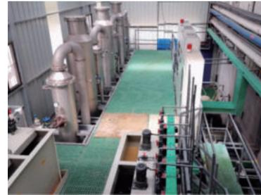
无锡瑞特(无锡工厂)废水零排放设备
